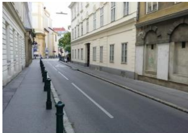
Slika 1. Postojeća zgrada – ulična fasada
