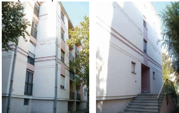
Слика 5: Изглед објекта
