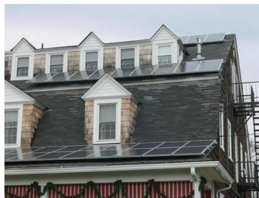
Slika 2. Solarni paneli na krovu Spring lake Inn-a
