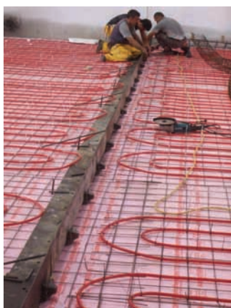
Slika 8. Radna dilatacija u podnoj ploči
