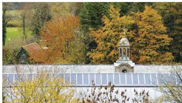
Slika 4. Solarni paneli, Arlington Court
