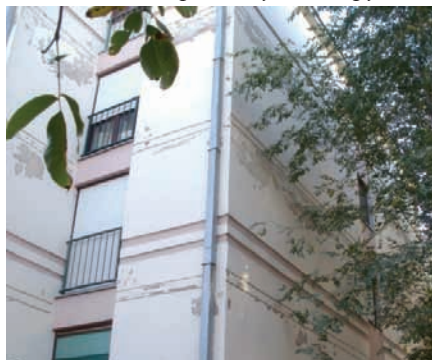
Слика 8: Отпадање фасадне боје
