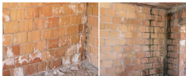
Слика 5. Кристализација соли и биолошка корозија на зидовима објекта.
