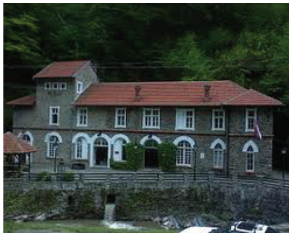
Slika 2. Izgled hidroelektrane “Vučje”
