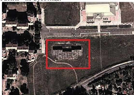
Слика 1. Сателитски снимак објекта.
