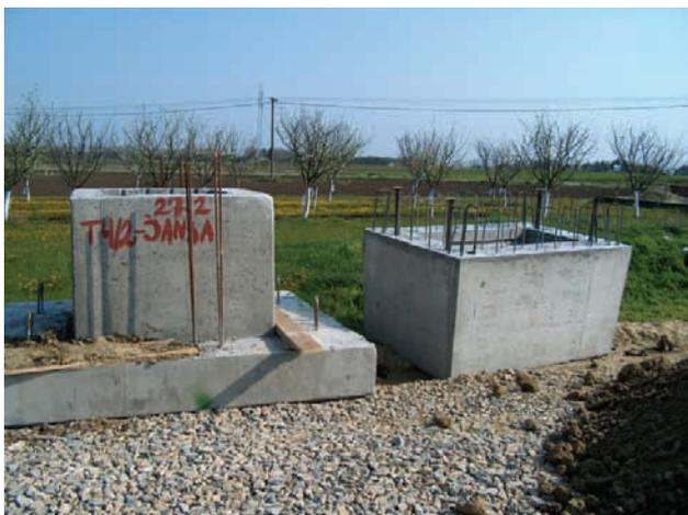
Slika 8. Prikaz montažne temeljne čašice i montažnog temelja sa čašicom
