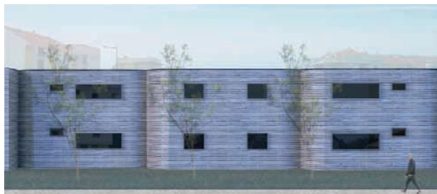
Fotografija 3: Fasade obložene drvenim panelima
