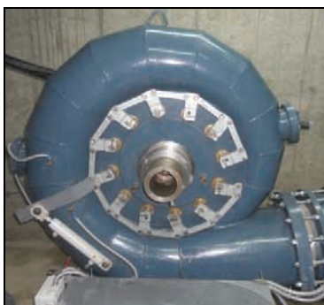
Slika 6 Fransis turbina u mHE Mokra Gora
