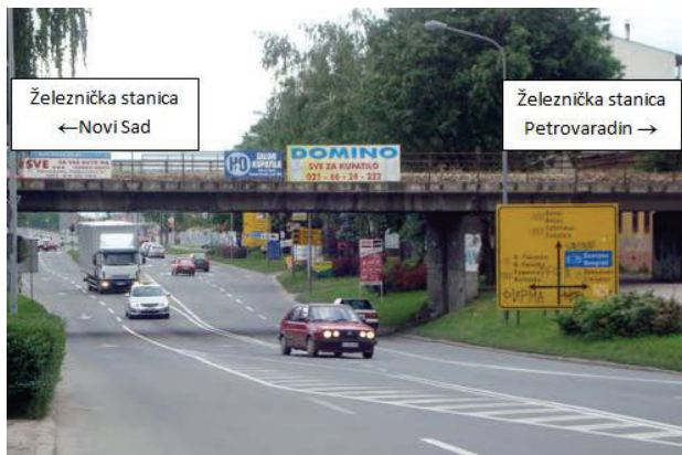
Slika 4- Podvožnjak u Temerinskoj ulici
