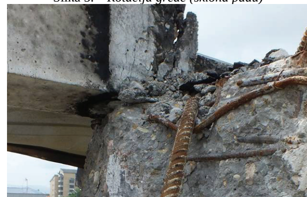
Slika 6. – Redukovana širina oslanjanja grede
