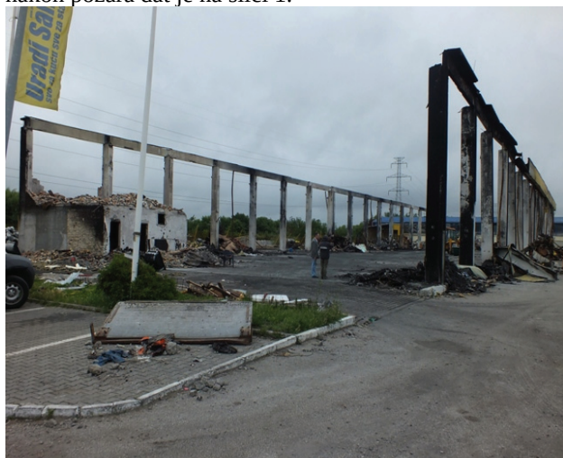
Slika 1. – Izgled objekta posle požara
