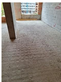
Слика 13. Седање бетона, АБ плоча
