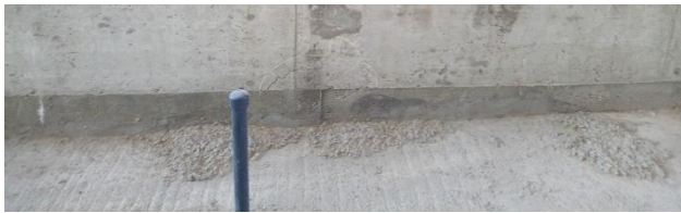
Slika 4. Ostaci betona nakon ugradnje
