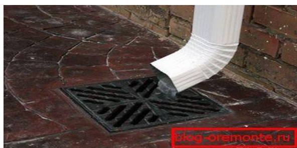
Слика 10. Изведен дренажни канал са олуком
