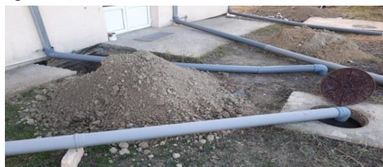
Слика 5. Приказ интервентне мере на олуцима
