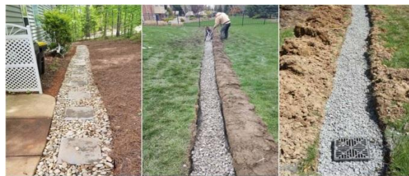
Слика 8. Финална фаза извођења дренажног канала и дренажног система – француска дренажа
