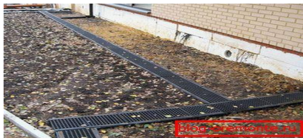
Слика 9. Изведен дренажни канал
