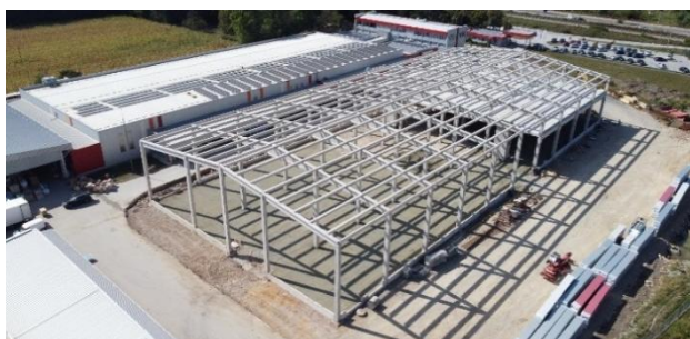
Slika 2. Izgled objekta „VEGA“ pogled na skladišni prostor
