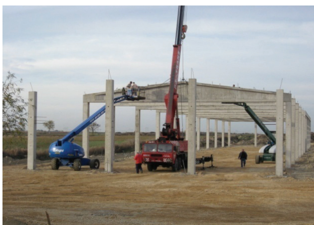
Slika 2. Montaža glavnog nosača
