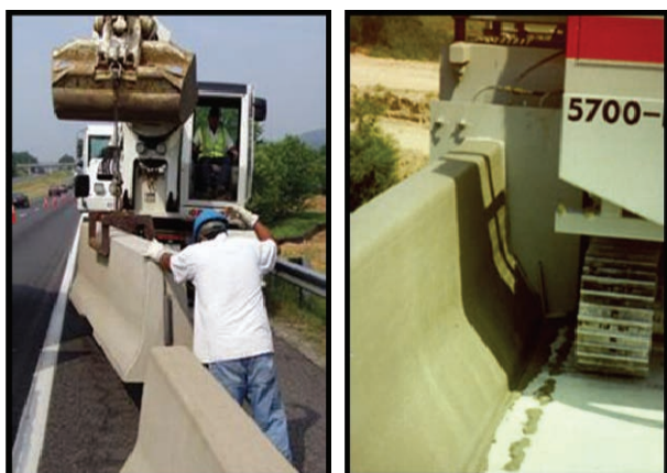
Slika 1. Mašinski i montažni način izvođenja barijera
