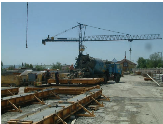
Slika 2. Čelični kalupi za izradu stubova
