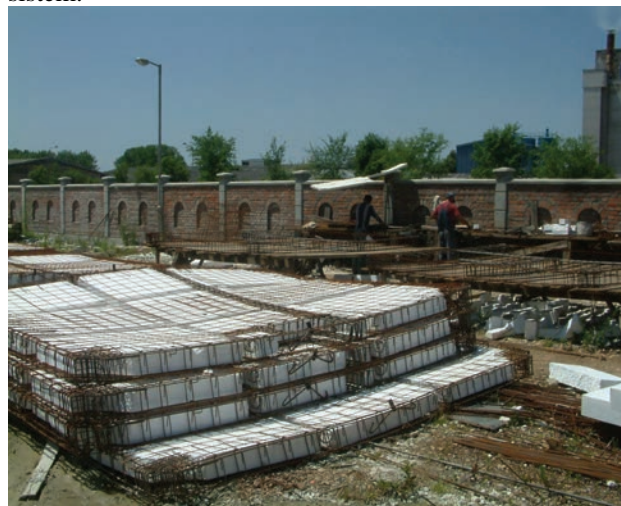
Slika 4. Gotovi armaturni sklopovi za montažne tavanice
