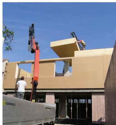
Slika 6. Primer postavljanja prefabrikovanog panela od komprimovane slame, [8]
