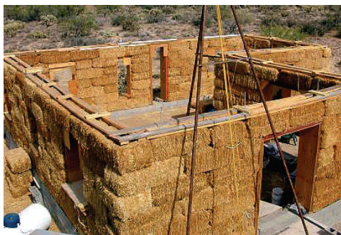
Slika 5. Sistem nosećih zidova od bala slame [8]
