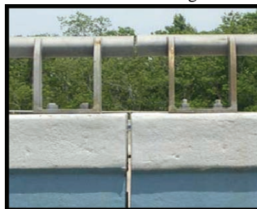
Slika 5. Spojnica između dva segmenta kombinovane zaštitne ograde
