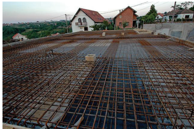
Slika 5. Armiranje pune ploče u monolitnom sistemu
