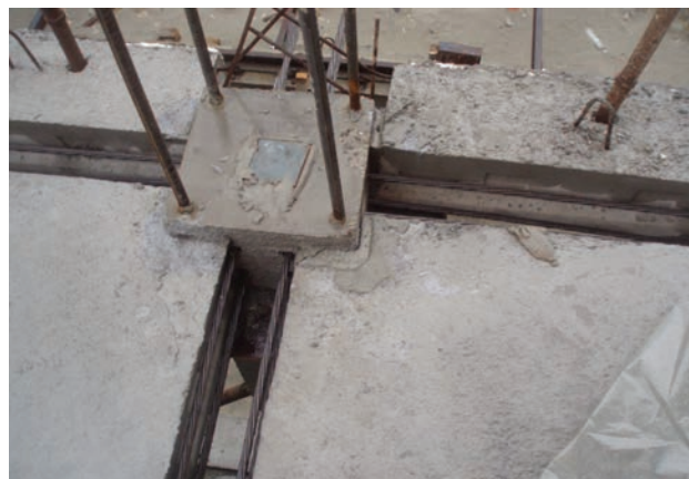
Slika 1. Povezivanje elemenata čeličnim kablovima
