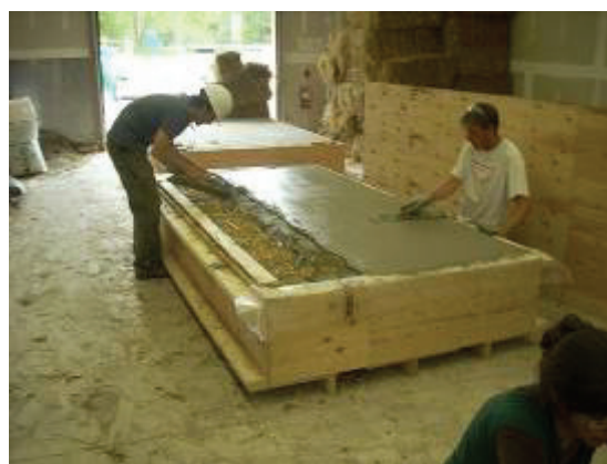
Slika 7. Primer završne obrade prefabrikovanog panela od komprimovane slame, [8]
