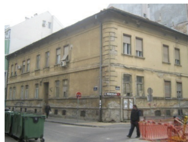
Слика 1. Изглед стамбеног објекта
