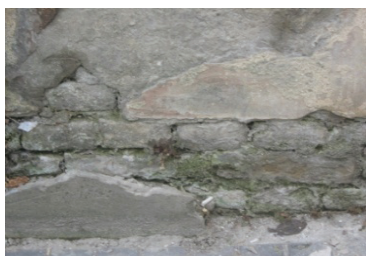
Слика 3. Локално испран малтер у спојницама, маховина и биљке у спојницама, зид у оси А
