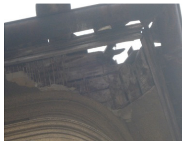
Слика 4. Оштећена надстрешница на углу зидова у осам А и 4
