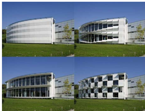
Slika 2. Kinetička fasada objekta Kiefer Technic
