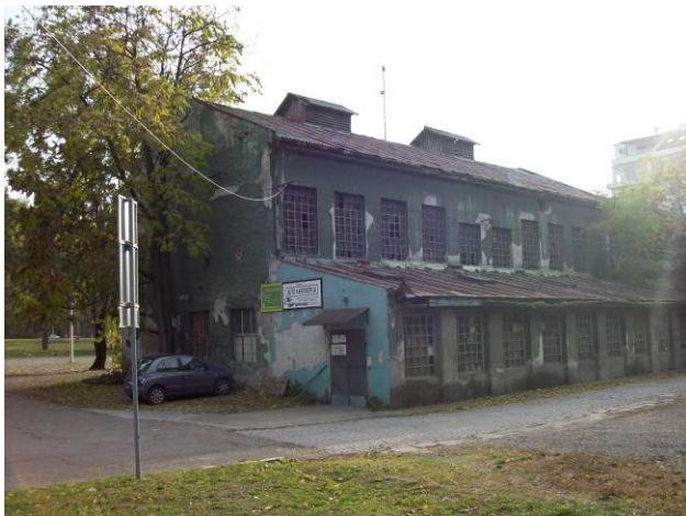
Sl. 2 Prikaz postojećeg stanja objekata
