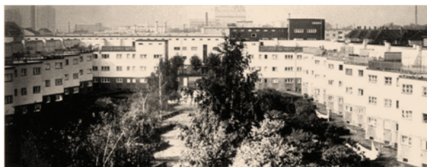
Slika 4. Izgled unutrašnjosti cik-cak bloka, naselje Niderad, Frankfurt
