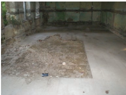
Слика 14. Дашчани под који је иструлио
