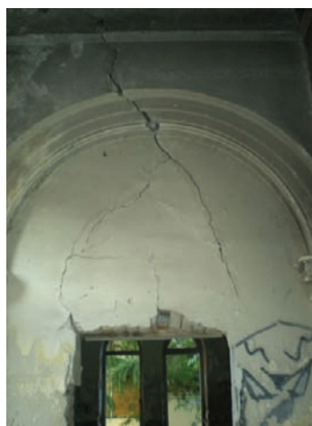
Слика 11. Пукотина изнад отвора за врата који је изведен као зидани раван лук
