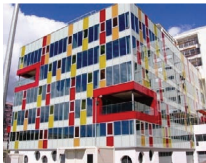
Слика 3. Фасада зграде од емајлираног стакла.
