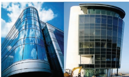
Слика 4. Рефлективно и антирефлективно стакло на фасадама.
