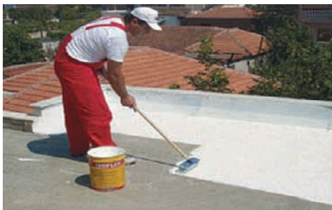
Slika 3: Nanošenje poliuretanskog premaza pomoću četke
