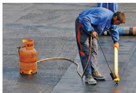
Slika 1: Varenje preklopa između bitumenskih traka
