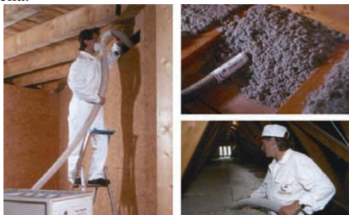
Slika 4. Ugradnja izolacije na osnovi celuloze
