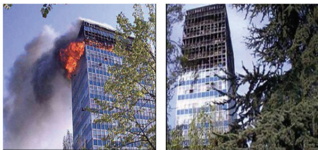
Slika 1. Izgled visokog poslovnog objekta - Radnički univerzitet "Radivoj Čirpanov" - za vreme i posle požara
