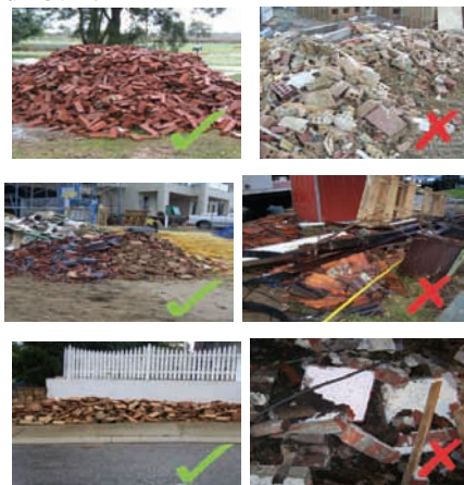
Slika 3. Sa leve strane pravilan način odvajanja građevinskog otpada, sa sa desne ne pravilan način
