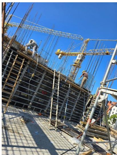
Слика 5. Извођење радова на бетонирању вертикалних АБ елемената
