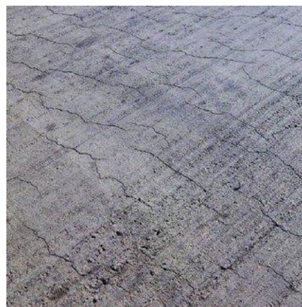
Слика 1. Иглед прслина и пукотина насталих услед пластичног скупљања бетона
