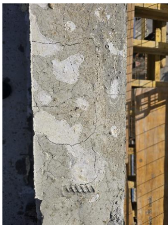
Слика 9. Седање бетона, АБ плоча
