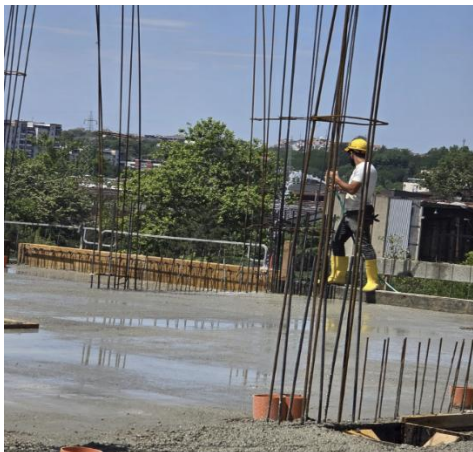
Слика 2. Заливање површине бетона
