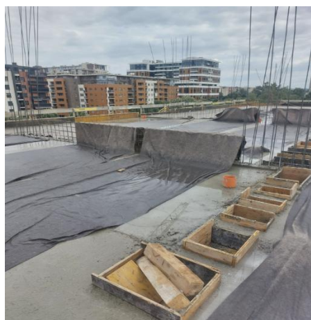
Слика 3. Прекривање плоче геотекстилом
