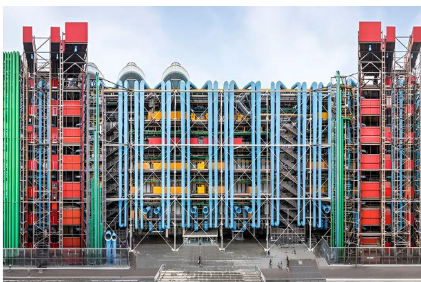
Слика 3. Фасада културног центра Жорж Помпиду
