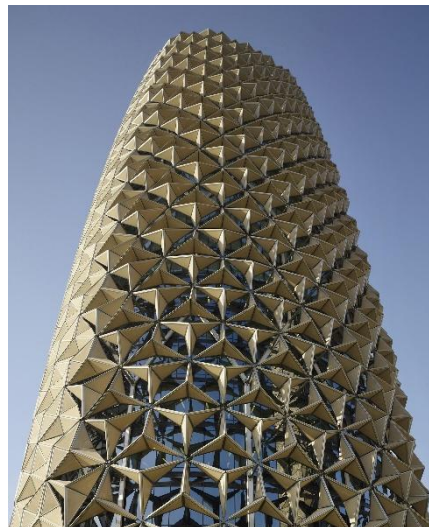
Слика 2. Al Bahr Towers, Абу Даби – пример адаптивне фасаде са контролисаном порозношћу и вентилацијом [6]
