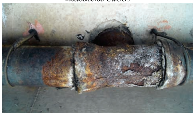
Слика 6. Корозија система за одводњавање
