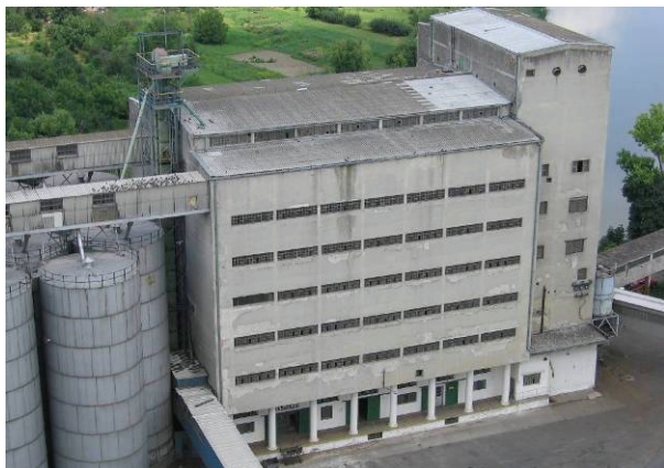
Slika 2. Izgled kompleksa mašinske kuće sa podnim skladištem i čeličnim silosom
