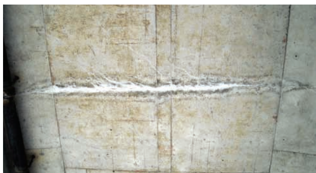
Слика 5. Растварање и испирање \text{Ca}(\text{OH})_2 и таложење \text{CaCO}_3
