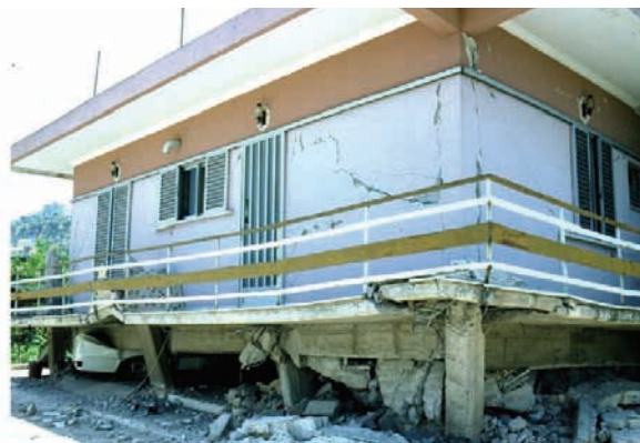
Slika 1. Kolaps prizemnih spratova usled redukcije ispuna
