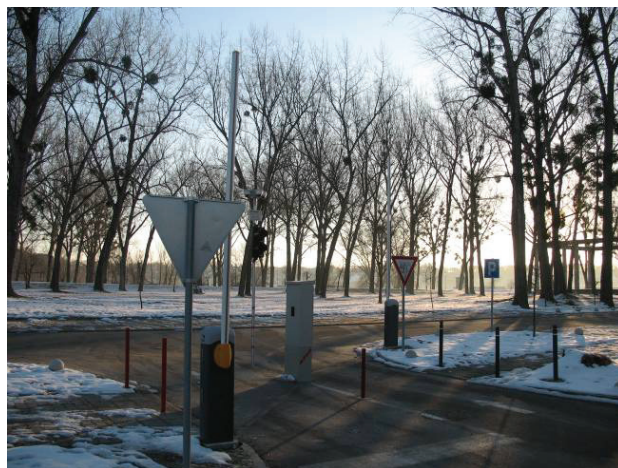
Slika 5 – Izgled sistema za kontrolu pristupa
