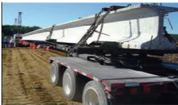
Slika 2. Transport montažnog nosača
