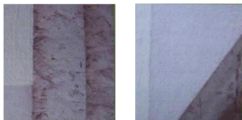
Slika 2: Zid malterisan Permalom i Supermalom i preko toga sloj Perlitfasa
