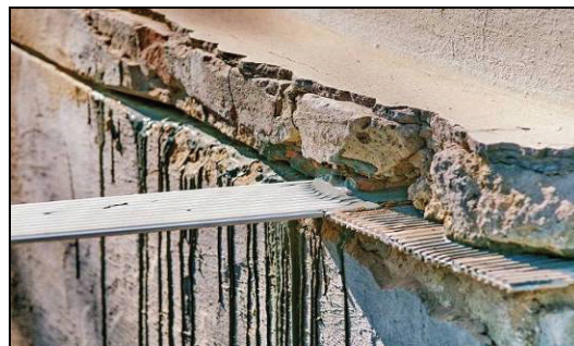
Slika 1. Ugrađivanje HIO-master šine
