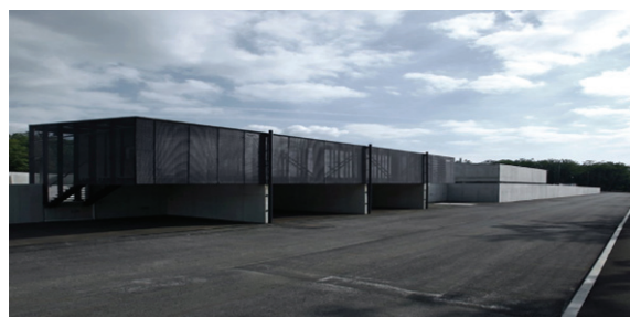
Slika 2. Izgled reciklažnog kompleksa na parceli
