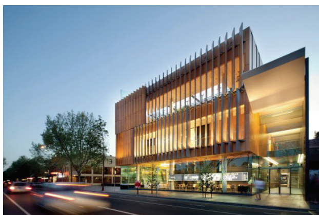
Sl.2 – Izgled objekta sa ulice
