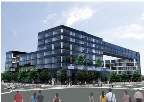
Slika 16. Pogled na objekat D sa osvrtnom na pasarelu
