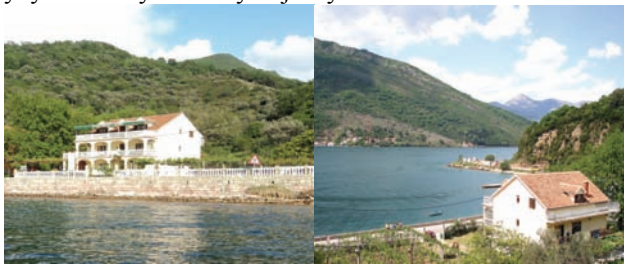
Слика 2. Изглед објекта
