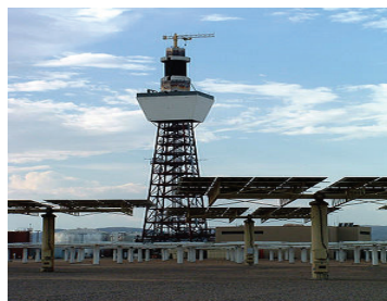
Slika 2.1. Kula za skupljanje solarne energije [8]
