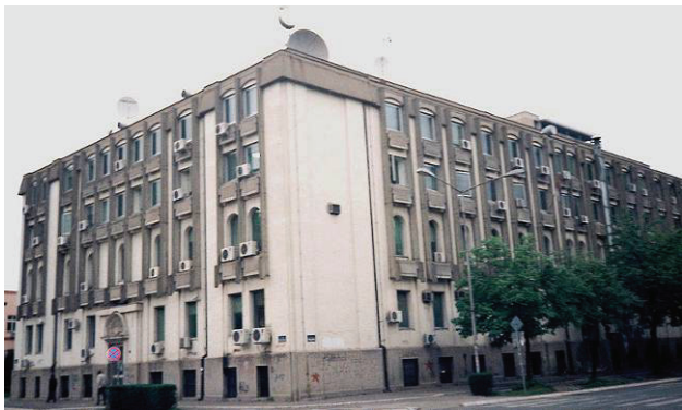
Slika 1 – Sadašnja zgrada RTV Novi Sad
