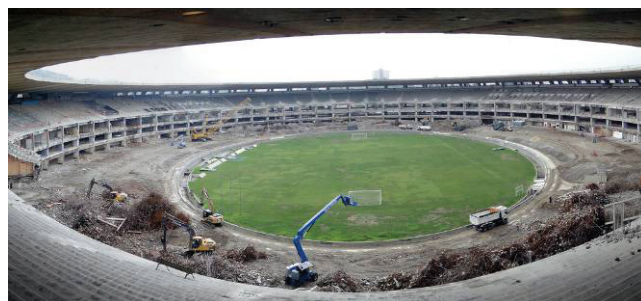
Слика 5: Рушење постојећих трибина
