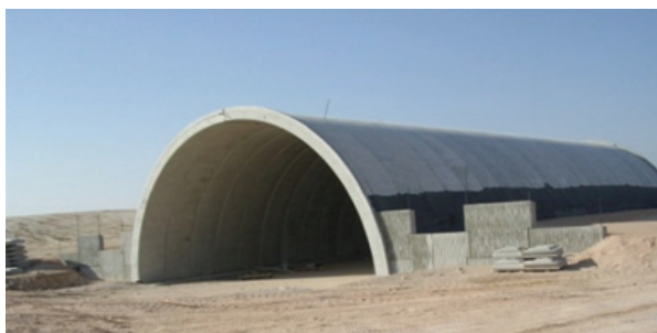
Slika 3. Izgled gotove TechSpan konstrukcije
