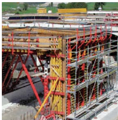
Slika 1. Oplata pravougaonog propusta
