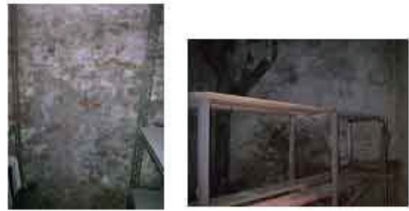
Slika 6.- Kristalizacija soli usled kapilarnog penjanja vode
