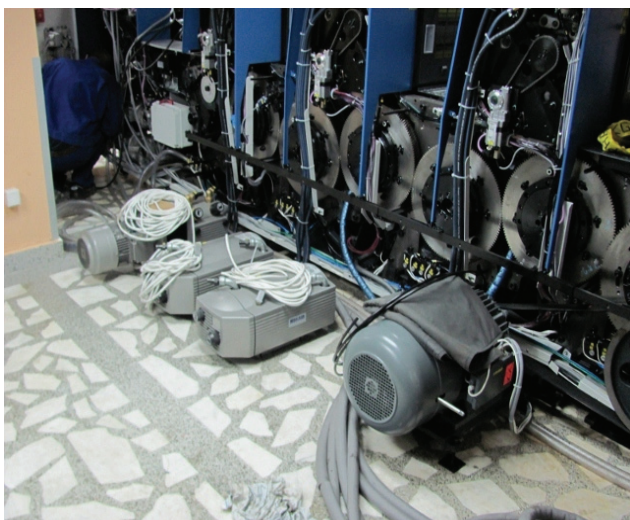
Slika 2. Rotacioni kompresori i elektromotor
