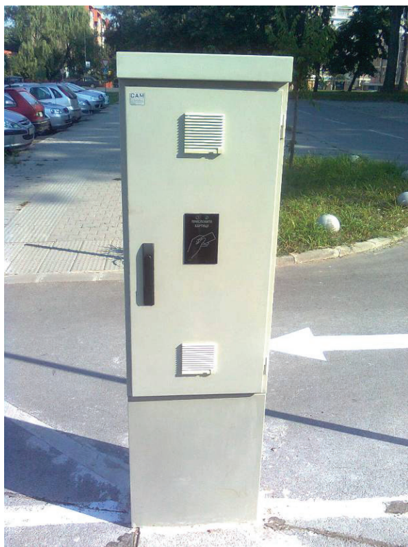
Slika 6. Upravljački orman za kontrolu pristupa parkinzima Univerziteta u Novom Sadu.
