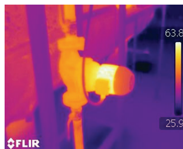
Slika 5: Detektovano povišeno zagrevanje pumpe i rezervoara termovizijskom kamerom
