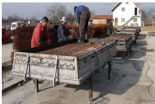
Slika 3. Priprema ferocementnog elementa za izlivanje
