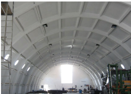
Slika 2. Unutrašnjost hale – lukovi i podužne grede
