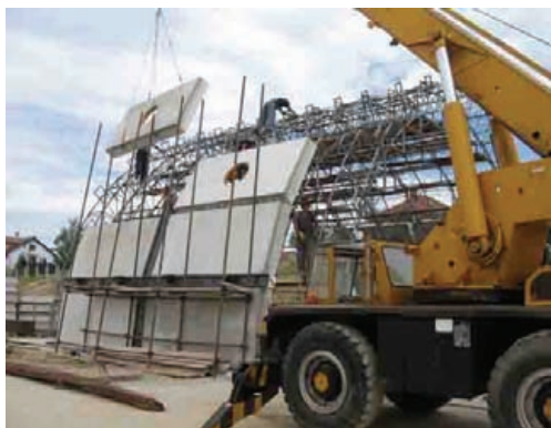
Slika 4. Montaža elemenata pomoću čelične lučne skele
