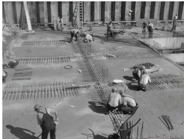
Slika 7. Armiranje temeljne ploče
