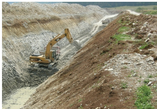
Slika 6. Terasasti iskop sa utovarom i odvozom
