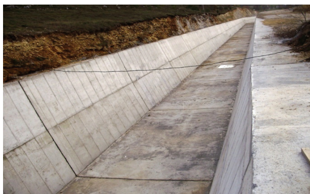
Slika 1. Betonska obloga kanala
