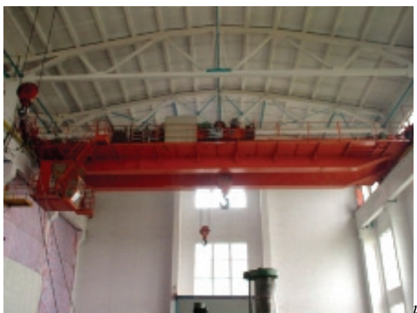
Slika 1. Mosni kran u okviru industrijske hale
