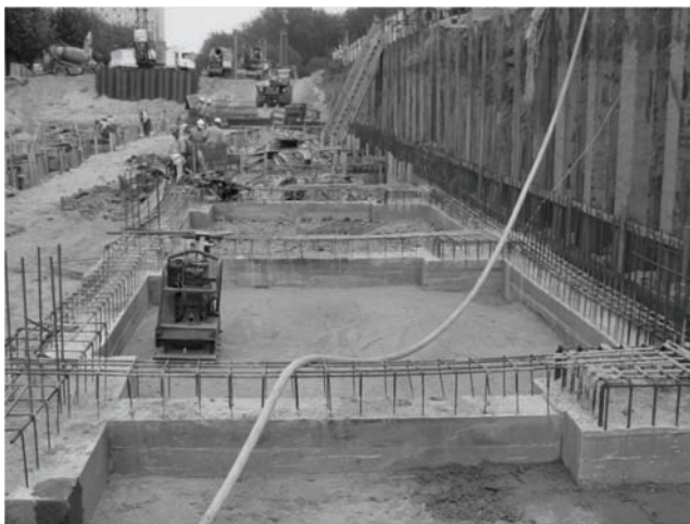
Slika 6. Temeljne stope i vezne grede
