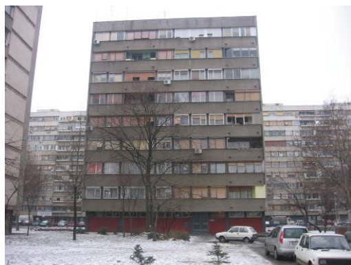
Slika 3: Izgled istočne fasade
