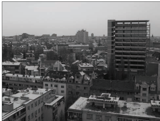
Slika 3 Postojeće stanje Radničkog univerziteta
