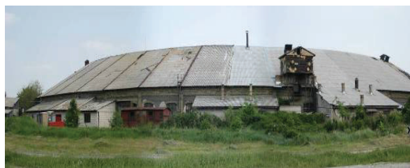
Slika 4. Zabušteni objekat Ložionice
