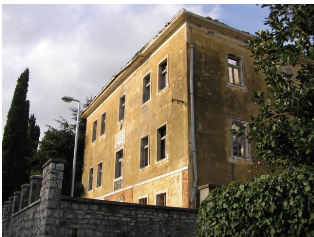
Sl. 2. Postojeće stanje zgrade zadužbine
