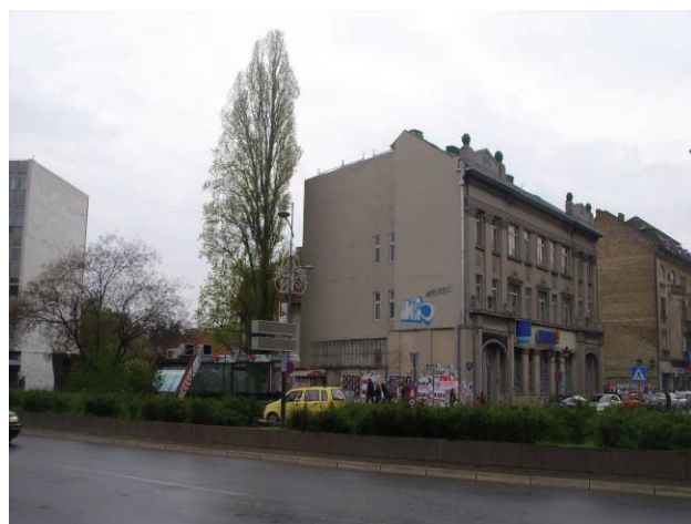
Sl.2 prikaz postojećeg stanja odabrane lokacije
