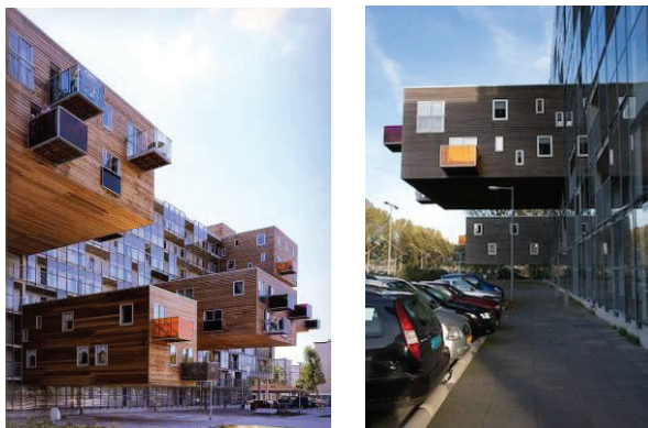
Slika br. 4 b i c – Pogled na objekat
