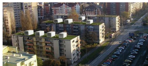
Slika 5. Postavka „slideBOX” jedinica na ravnim krovovima
