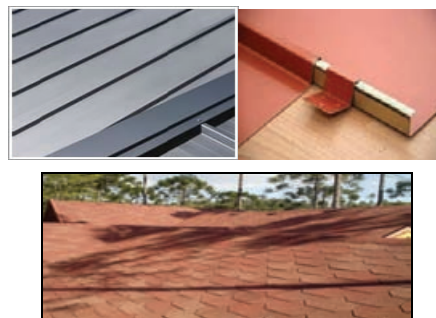
Slika 5- profilisani lim , limeni krovni pokrivač-detalj i šindra-“Liberty”
