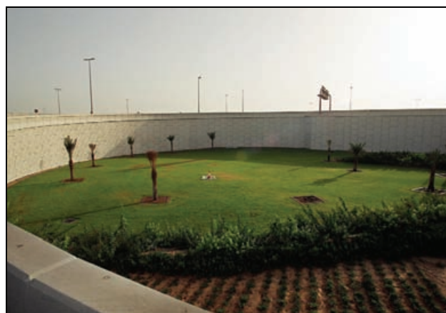
Slika 1. Izgled MSE potpornog zida
