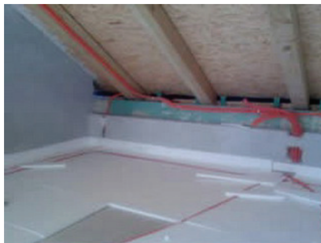
Slika 2. Postavljanje izolacije
