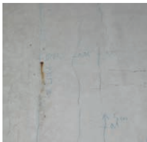
Slika 9. Vertikalne prsline
