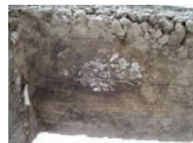
сеграгација бетона
