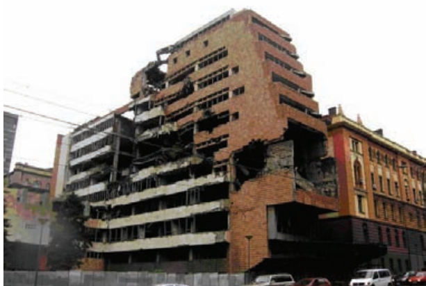
Slika 4. Postojeće stanje zgrade Generalštaba
