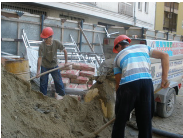
Slika 4. Spravljanje cementnog maltera
