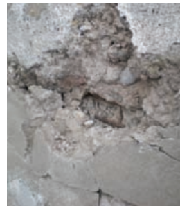
Slika 5. Betonsko gnezdo
