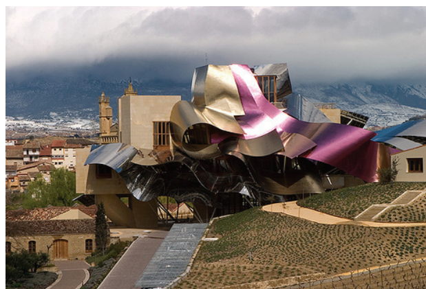
Sl. 3. Hotel Marques de Riscal, Španija
