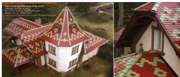
Slika 3-Ukrasni crep na upravnoj zgradi-Zoo vrta Palić
