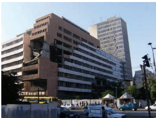
Slika 5. Postojeće stanje zgrade Generalštaba
