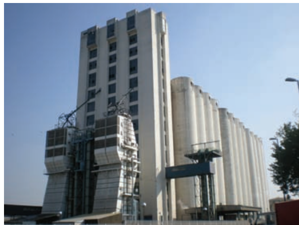
Slika 2. Izgled baterija silosa i mašinske kuće
