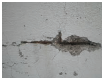
Slika 6. Korozija armature
