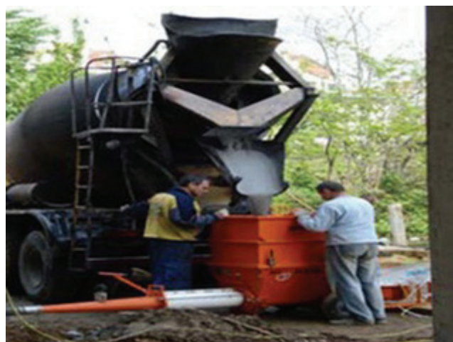
Slika 3. Isporuka maltera na gradilište
