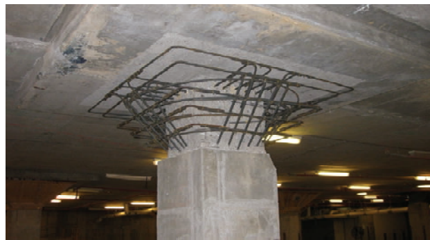
Slika 6. Armiranje naknadno izvedenog kapitela
