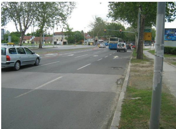
Slika 2. prilaz 4 (Futoški put) sa pogrešno obeleženom namenom saobraćajne trake
