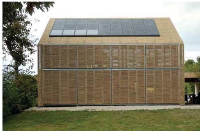
Slika 1. Južna fasada objekta, bambusove stabljike
