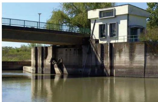
Slika 11. Ustava na kanalu DTD kod Opova
