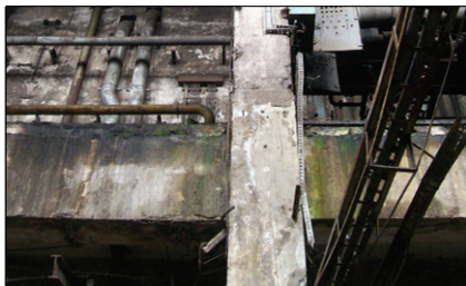
Slika 8. Biološka korozija
