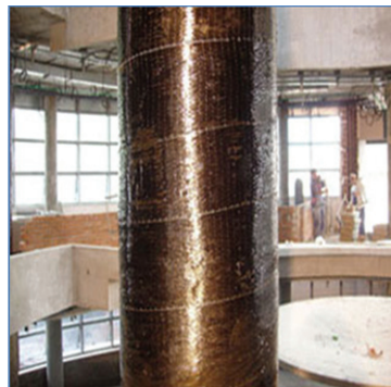
Slika 2. Ojačanje stuba karbonskom tkaninom
