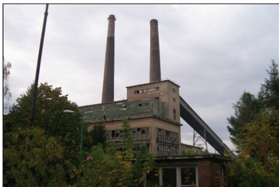
Slika 3 - Sadašnji izgled objekta termoelektrane
