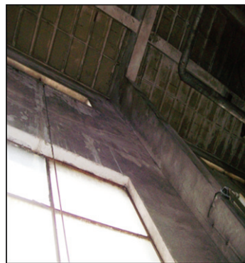
Slika 12. Izgled krovne konstrukcije sa unutrašnje strane
