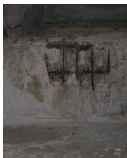
Slika 11. Korozija armature
