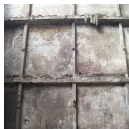
Slika 15. Dejstvo vlage na zid
