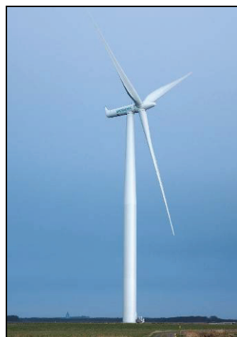
Slika 2. - Izgled montirane turbine SWT 2,3-101
