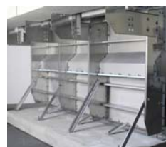
Slika 8. Konstrukcija zidnih panela tipa Myrtha pool
