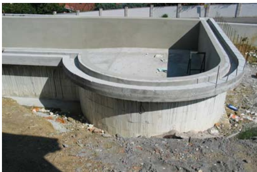
Slika 1. Betonska konstrukcija bazena sa urađenim prelivnim kanalom
