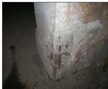
Slika 7. Korozija armature
