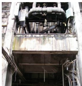
Slika 12. Biološka korozija
