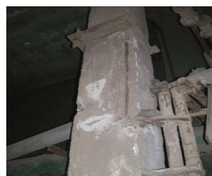
Slika 10. Korozija armature
