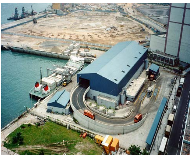
Slika 4.1 Stanica za transfer otpada
