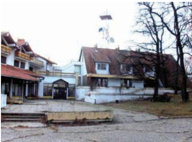
Slika 2. Izgled postojećeg objekta na Brankovcu
