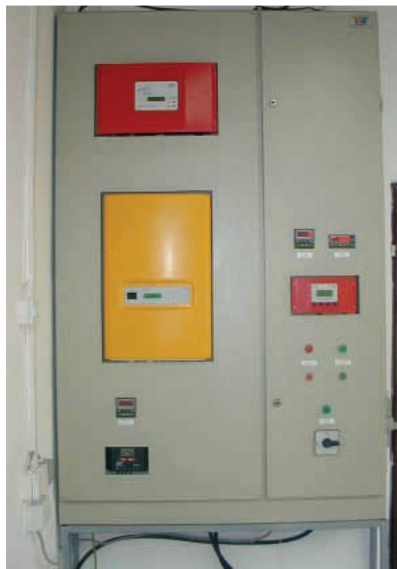
Slika 4. Prikaz komponenti sistema i prednje strane komandnog ormana
