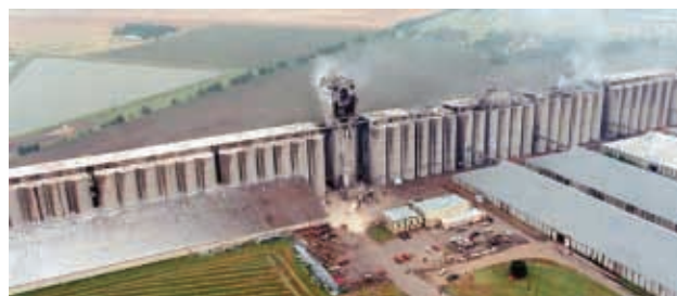
Sl. 1. Eksplozija elevatora u silosima "DeBruce Grain" Haysville (Kansas, USA) – jun 1998.
