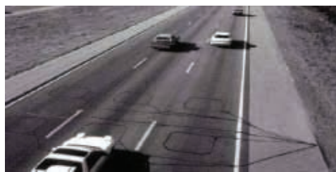
Slika 3. Parovi induktivnih petlji
