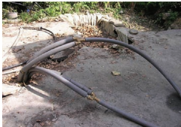
Slika 2. Postavljanje „geosondi“
