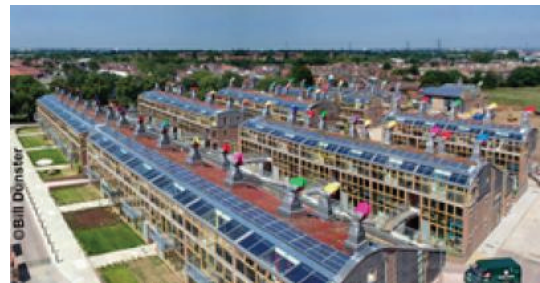
Slika 1. Stambeni kompleks BedZED u Engleskoj
