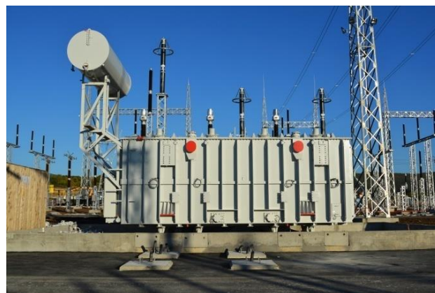
Slika 1. Trofazni uljni transformator 2ARZd 300000-420, Končar
