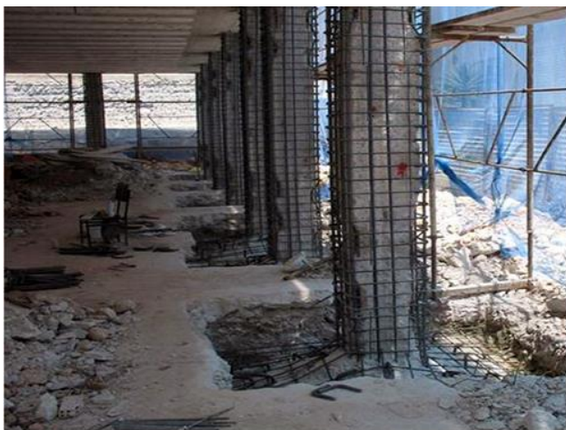
Slika 4.3. Primjer ojačanja stubova prizemlja
