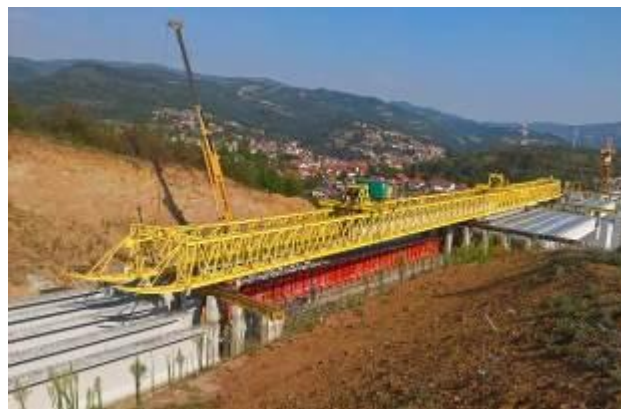
Slika 1. Lansirna rešetka na mostu
