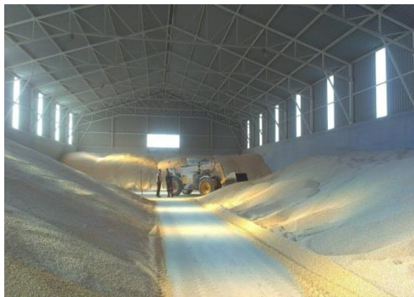
Slika 4. Primer podnog skladišta
