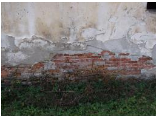
Slika 1 - Izgled donjeg spoljašnjeg dela zida, otpadanje i krunjenje maltera, ogoljene opeke, tragovi soli, promena boje na fasadi
