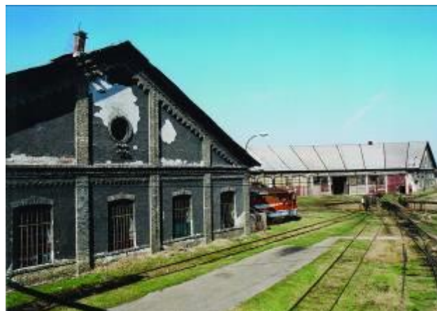
Slika 2 - Postojeće stanje ložionice u okviru kompleksa ranžirne stanice
