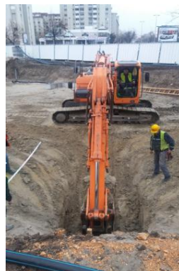
Слике 3 и 4. Ископ и монтажа контрафора
