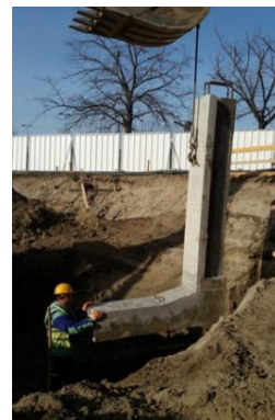
Слике 3 и 4. Ископ и монтажа контрафора
