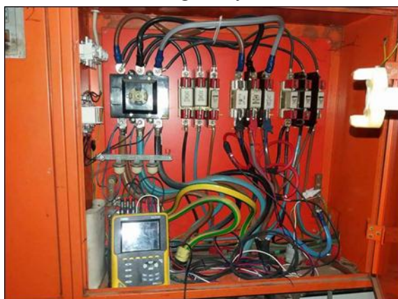
Slika 4. Postavka mernog uređaja CA 8332 u GA 90 VSD.
