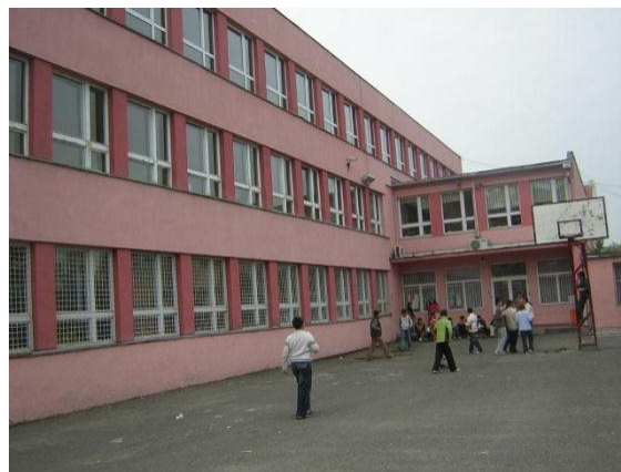
Слика 1. Изглед школског објекта
