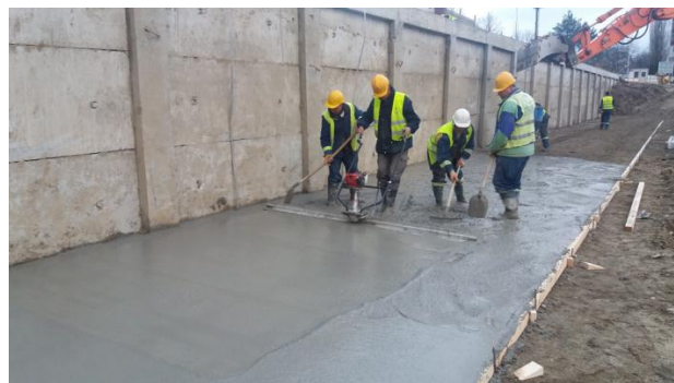
Слика 6. Израда подложног бетона
