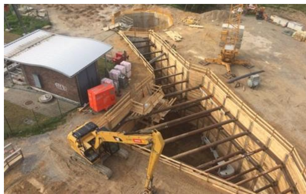
Слика 1. Berliner Verbau, Hirschberg, Germany
