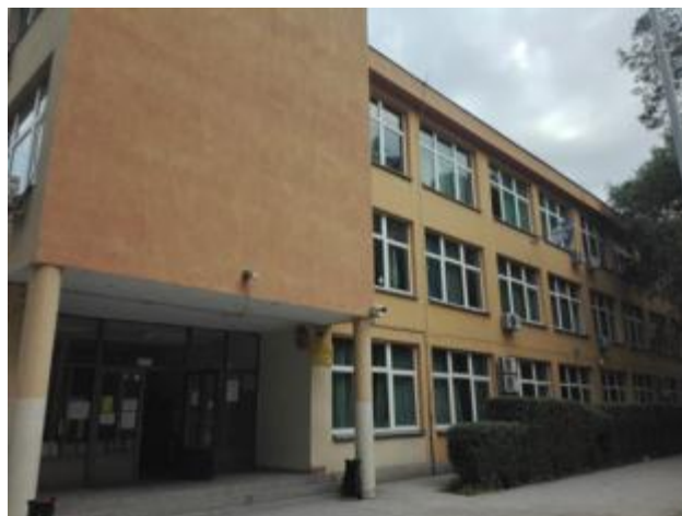
Слика 1. Изглед школског објекта
