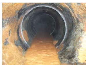
Слика 3. Унутрашњост цевовода DN 500 испред бунара БХД 8 на Рибарској ади – после чишћења –[3]
