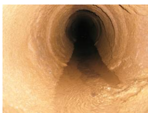
Слика 2. Унутрашњост цевовода DN 500 испред бунара БХД 8 на Рибарској ади – пре чишћења –[3]
