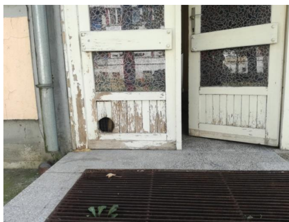
Slika 4. Dotrajalost stolarije, izloženost atmosferskim uticajima bez adekvatnog održavanja
