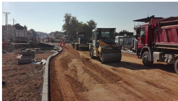
Slika 5.2. Mehanizacija na gradilištu
