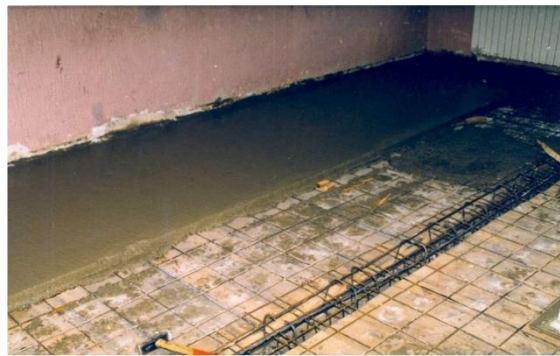
Slika 7. Sprezanje tavanice, drvo/beton
