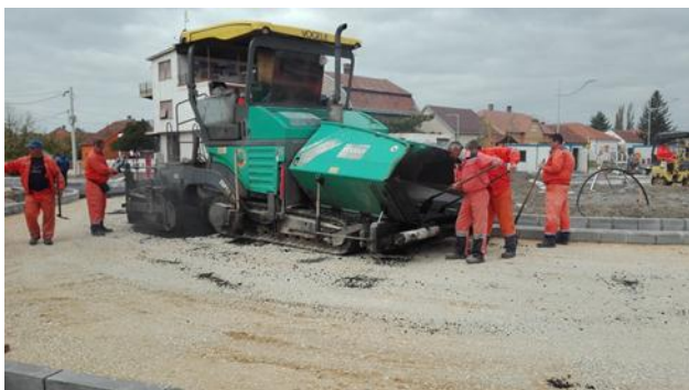
Slika 5.1. Radnici na asfaltiranju
