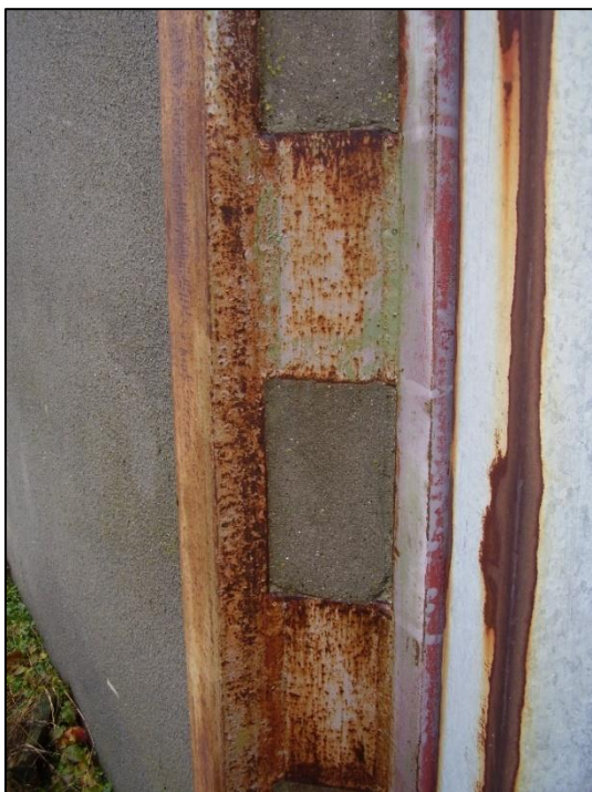
Slika 6. Korozija stuba
