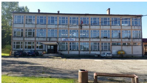
Slika 1. Izgled objekta (sjeverna strana)
