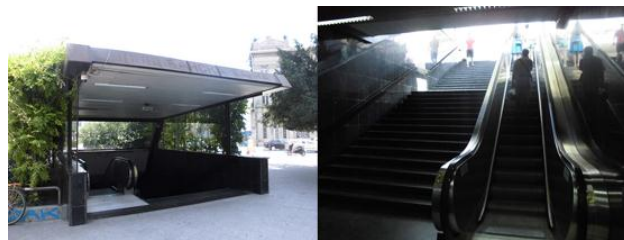
Слика 3. Подземни пролаз на улици Михајла Пупина у Новом Саду
