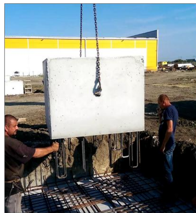
Slika 2. Postavljanje temeljne čaše
