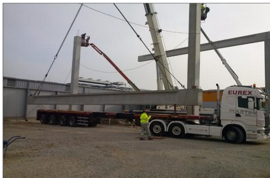
Slika 5. Podizanje elementa sa kamiona
