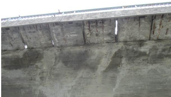
Slika 8. Montažne ploče pešačkih staza sa donje strane
