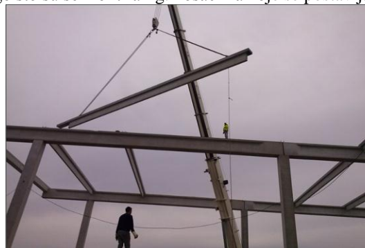
Slika 7. Montaža rožnjače preko prepreke
