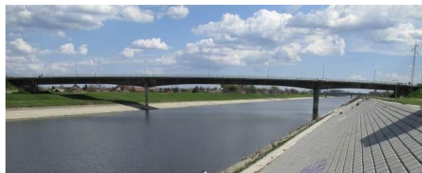
Slika 6. Izgled Klisanskog mosta
