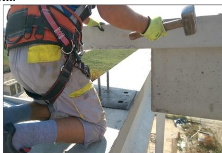
Slika 8. Spoj glavnog nosača i rožnjače
