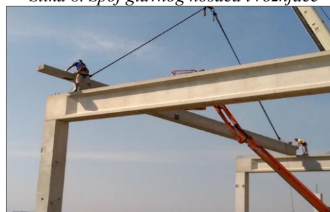
Slika 9. Postavljanje rožnjače na nosač
