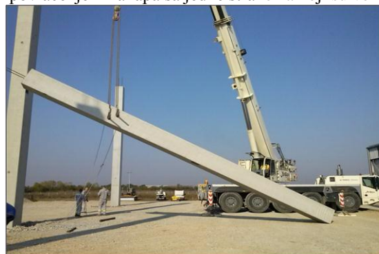
Slika 3. Zahvatanje i podizanje stuba
