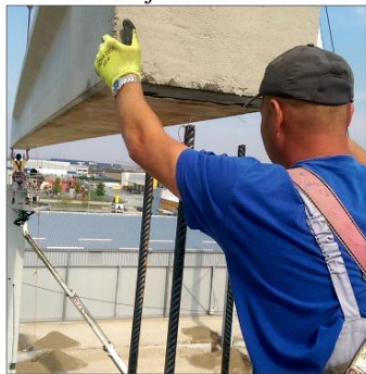
Slika 6. Spuštanje i postavljanje elementa
