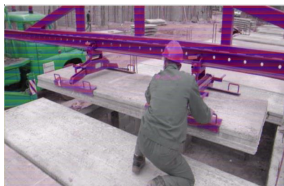
Slika 2. Montaža prednapregnutih ošupljenih ploča
