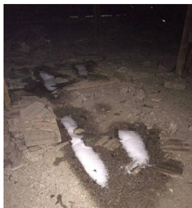
Slika 8. Atmosferilije na međuspratnoj tavanici
