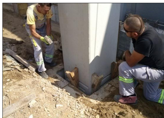
Slika 4. Privremeno učvršćavanje stuba
