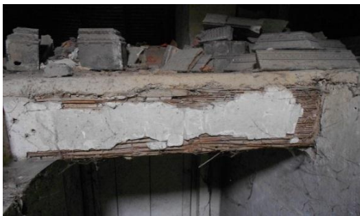
Slika 8. Debljina međuspratne tavanice
