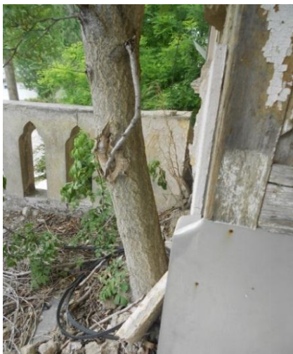
Slika 5. Prolaz stabla drveta kroz ploču balkona
