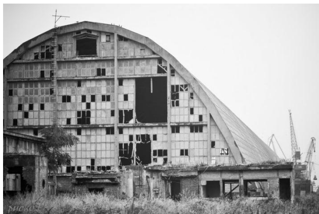
Slika 2. Postojeće stanje objekta
