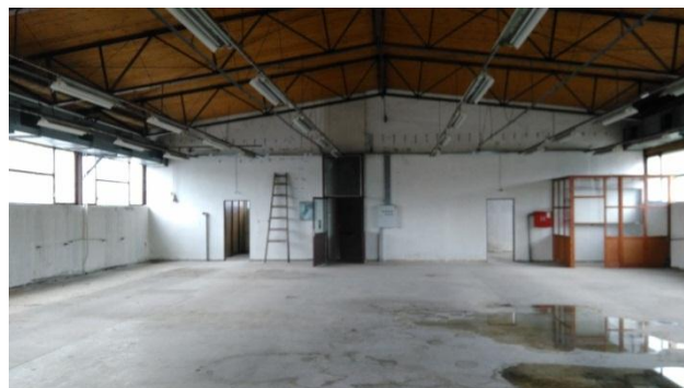
Slika 2. Postojeći objekat pogona „Svila“
