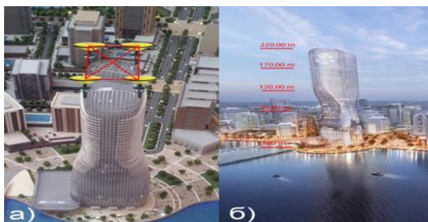
Slika 6. (a) Položaj GNSS uređaja (b) Položaj inklinometara
