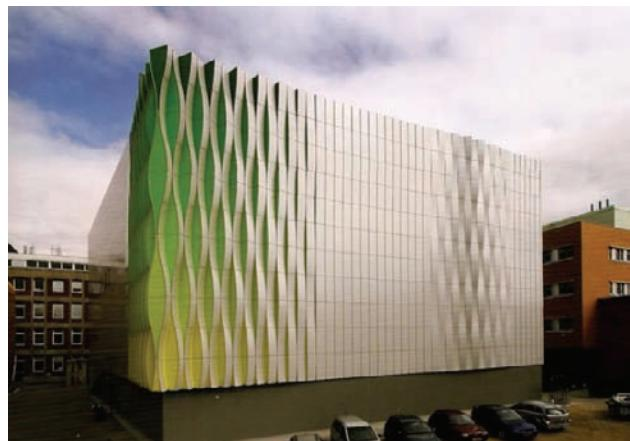
Slika 2. Primjer fasade Istraživačke laboratorije u Groningenu; Žuta boja na mjestima slabe osvjetljenosti
