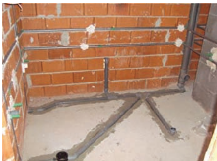
Slika 1. Razvod kanalizacije u sanitarnim čvorovima
