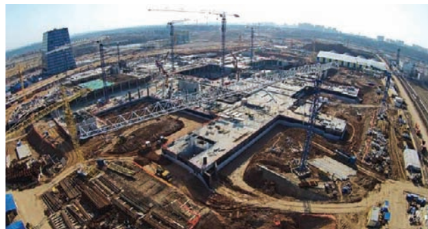
Slika 1. Gradilište Skolkovo, april 2015.god.
