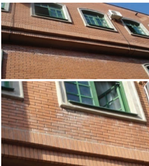
Slika br 7 i 8.-Isoljavanje na fasadnoj cigli, usled prisustva soli i vlažne atmosfere
